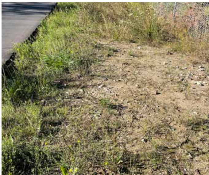
Reference - Process mod en biodivers beplantning på eksisterende bærelag
